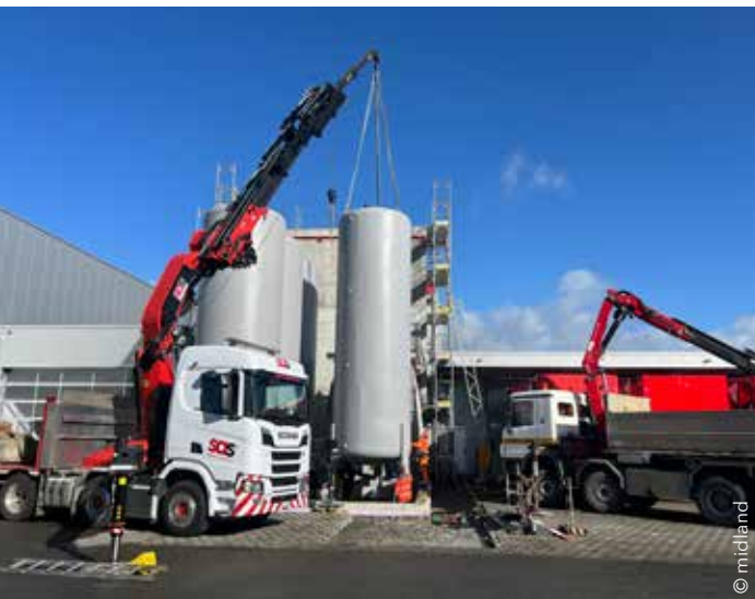
Installation de l'un des cinq réservoirs d'additifs supplémentaires.
